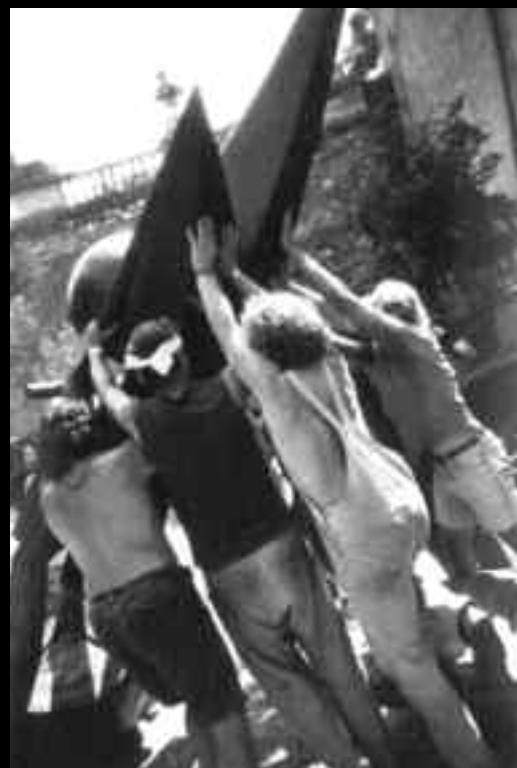
A pak se zase pracovalo. Instalace soch byla opravdu obtížná.
